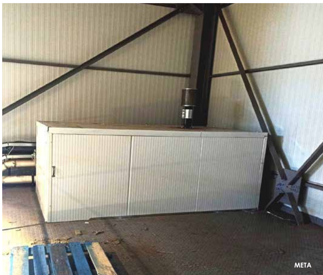
Ηχομόνωση αντλίας κενού σε βιομηχανία
