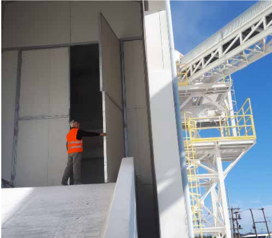
Πολύφυλλη ηχομονωτική θύρα σπαστήρα ορυκτών
