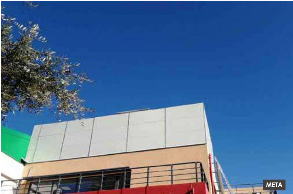
Ηχοπέτασμα σε κλιματιστικές μονάδες κολυμβητηρίου
