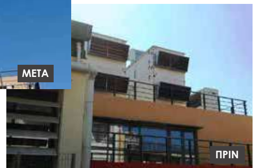
Ηχοπέτασμα σε κλιματιστικές μονάδες κολυμβητηρίου
