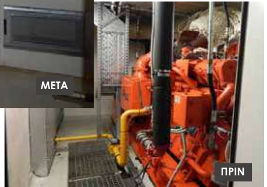
Ηχομονωτικό δωμάτιο μονάδας συμπαραγωγής σε ξενοδοχείο
